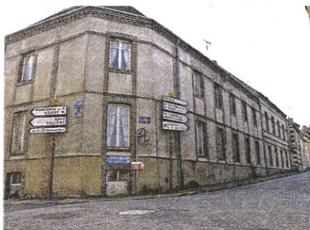
Ce bâtiment sera détruit pour plus de sécurité et d'ouverture.
